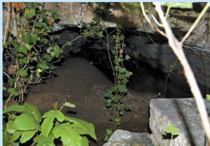
PASSAGE SOUTERRAIN DE L'AQUEDUC DES MOULINS
