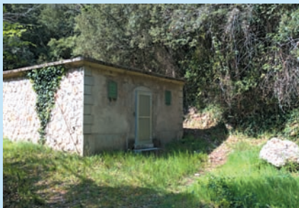
CAPTAGE DES FRAYÈRES
