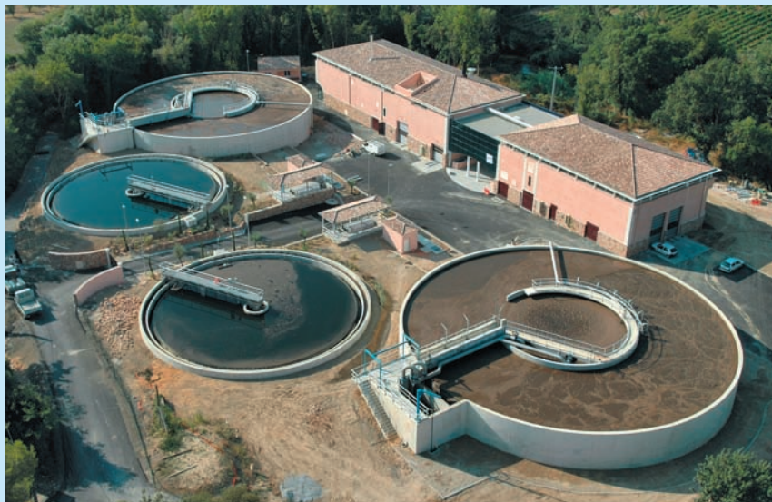
LA NOUVELLE STATION D'ÉPURATION DE DRAGUIGNAN TRANS-EN-PROVENCE - ©MAIRIE DE DRAGUIGNAN
