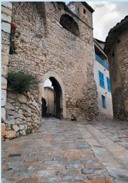
CANIVEAU CENTRAL À BARGEMON
