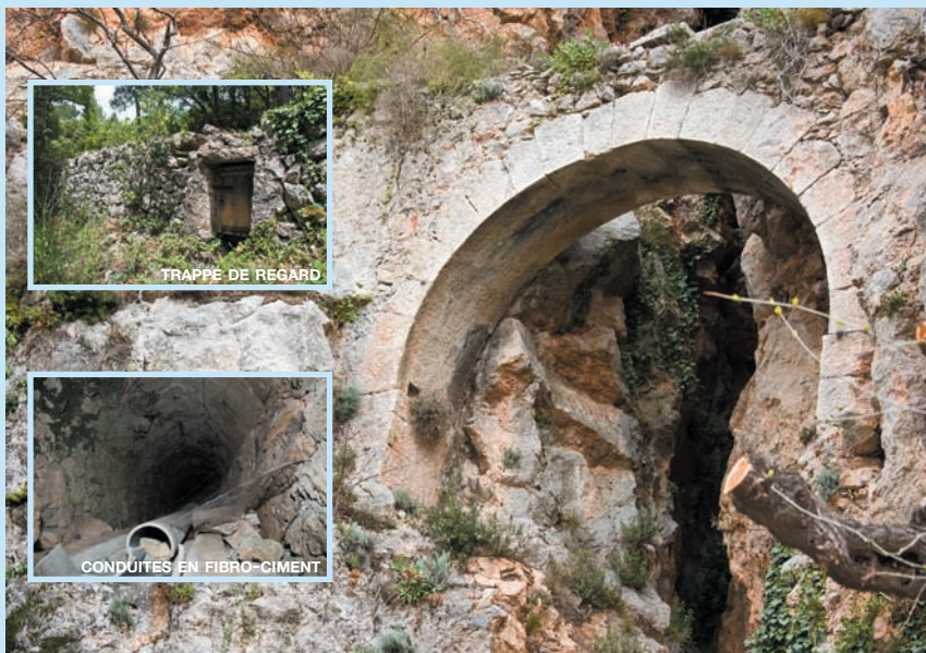
ARRIVÉE DE L'AQUEDUC À CHATEAUDOUBLE
