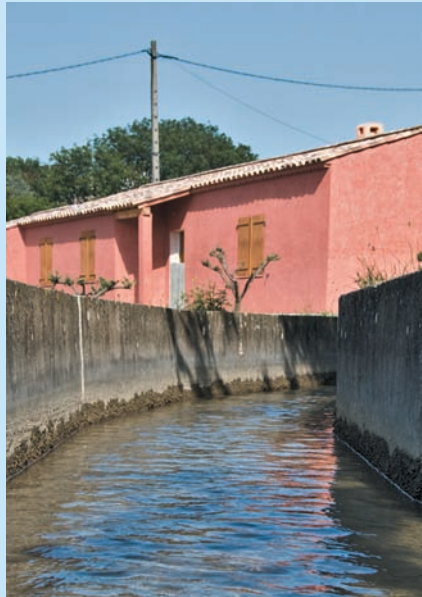
LE CANAL SE FAUFILE ENTRE LES HABITATIONS
