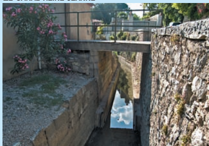
L'AQUEDUC DES MOULINS TRAVERSE DRAGUIGNAN
